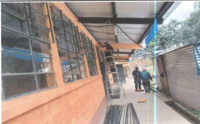
Foto 1: Pintando las paredes del instituto.
