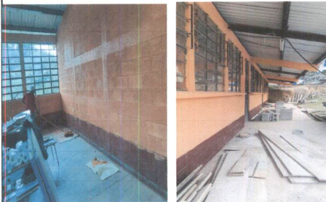
Foto 4: Pintando las paredes interior y exterior del instituto.
