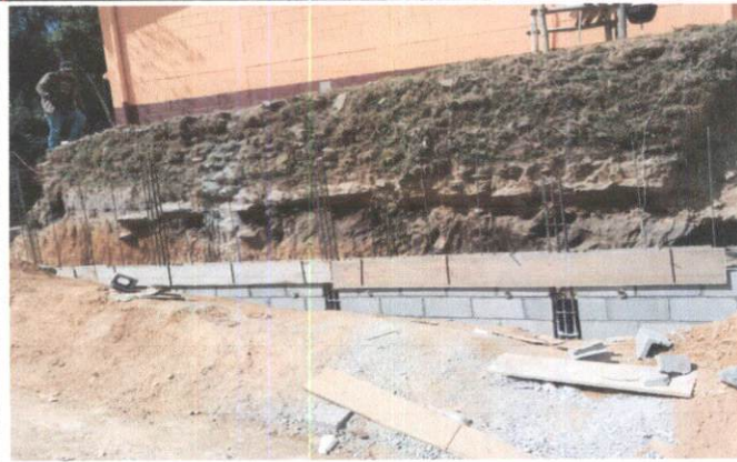
Foto 2: Levantamiento del muro perimetral del instituto.
