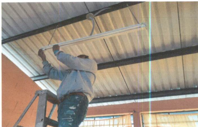
Foto 3: Instalando los tubos led del sistema eléctrico del instituto.
